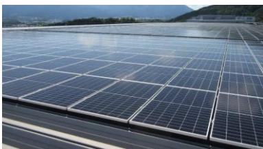
太陽光パネルの設置
