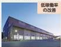
MJロジパーク春日井1
