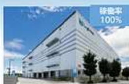
ロジクロス厚木Ⅱ (35千m 2 ) 2019年竣工(単独開発)
