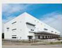
MJロジパーク厚木1
