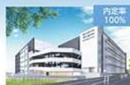
ロジスタ・ロジクロス筑木彩都(A棟) (115千m 2 ) 2021年竣工予定
