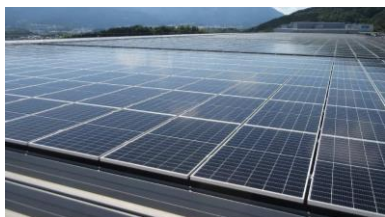
太陽光パネルの設置
