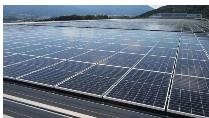
太陽光パネルの設置
