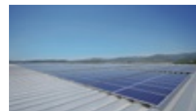
太陽光パネルの設置
