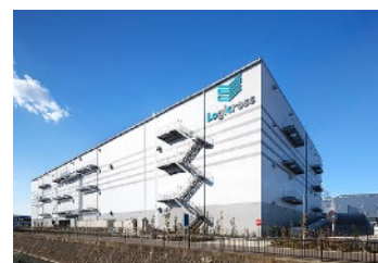
ロジクロス海老名 2020年11月竣工
