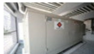
非常用発電設備の設置
