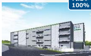
内定率 100% ロジスタ・ロジクロス茨木彩都 (B棟) (31千m 2 ) 2021年竣工予定
