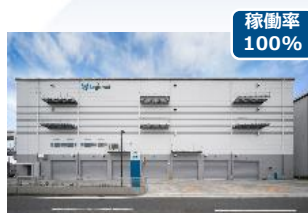
稼働率 100% ロジクロス横浜港北 (16千m 2 ) 2019年竣工
