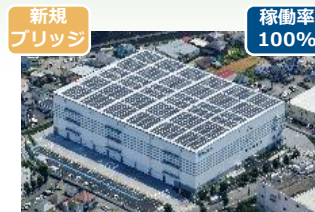
ロジクロス厚木Ⅱ (35千m 2 ) 2019年竣工
