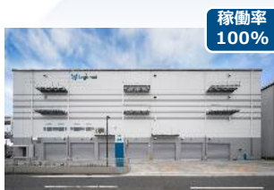
ロジクロス横浜港北 (16千m 2 ) 2019年竣工
