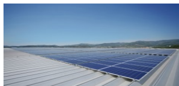
太陽光パネルの設置
