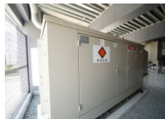
非常用発電機の設置
