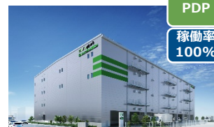
(仮称) MJロジパーク高槻1 (19千m 2 ) 2021年竣工
