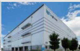
ロジクロス厚木II
