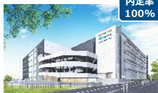
ロジスタ・ロジクロス茨木彩都 (A棟) (115千m 2 ) 2021年竣工予定
