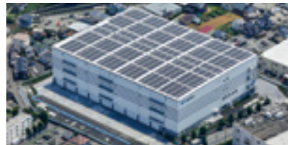
ロジクロス厚木II
