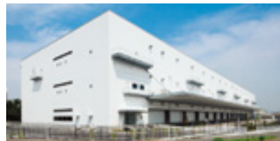
MJロジパーク厚木1
