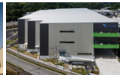
MJロジパーク印西1
