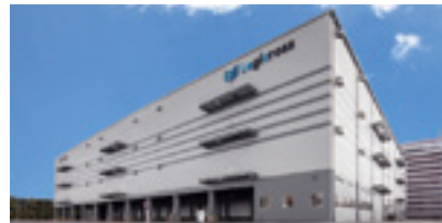
ロジクロス習志野
