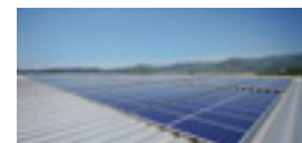
太陽光パネルの設置
