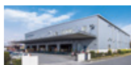
MJロジパーク加須1 BELS：評価ランク★★★★★
