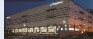
ロジクロス習志野
