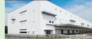
MJロジパーク厚木1
