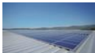
太陽光パネルの設置
