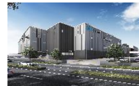
(仮称) ロジクロス蓮田 (79千㎡) 2021年竣工予定
