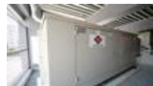
非常用発電設備の設置
