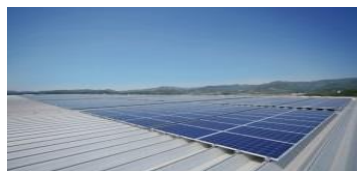
太陽光パネルの設置
