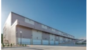
MJロジパーク春日井1
