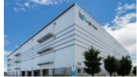
ロジクロス厚木 II
