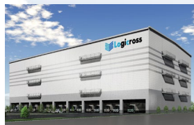
(仮称) ロジクロス船橋 (23千㎡) 2021年度竣工予定
