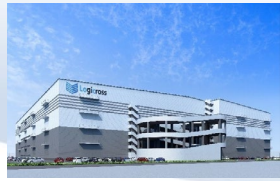
(仮称) ロジクロス座間 (183千㎡) 2023年度竣工予定
