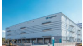
ロジクロス習志野
