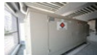
非常用発電設備の設置
