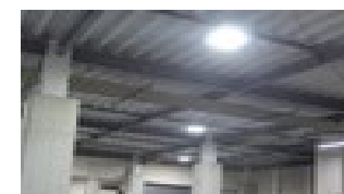
グリーンリース契約に基づくLED化改修
