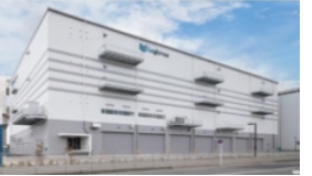
ロジクロス横浜港北
