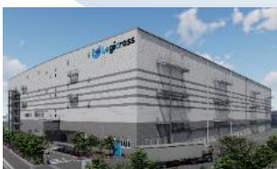
ロジクロス座間小松原 (44千m 2 ) 2022年竣工予定
