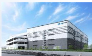
(仮称) 相模原市中央区淵野辺 プロジェクト (173千m 2 ) 2023年竣工予定
