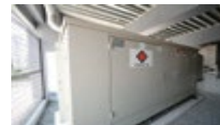
非常用発電設備の設置
